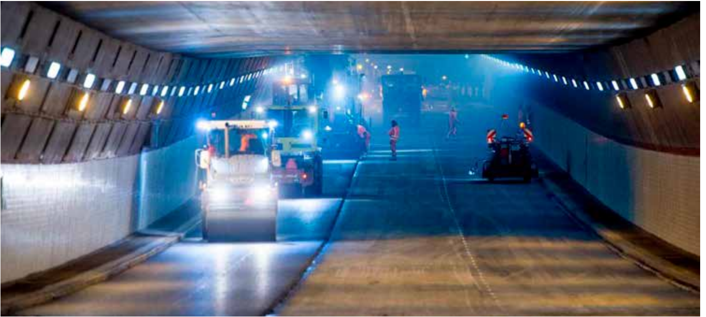
Trabajos de SICE en los túneles de Goteburgo
