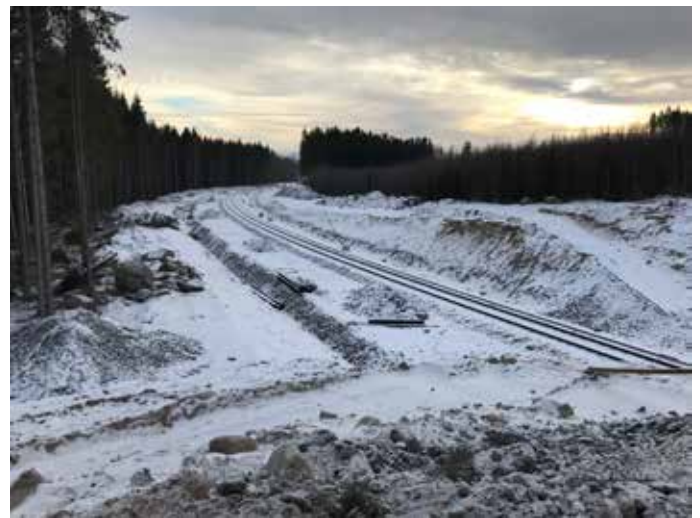
Tramo de alta velocidad Kardonbanan
