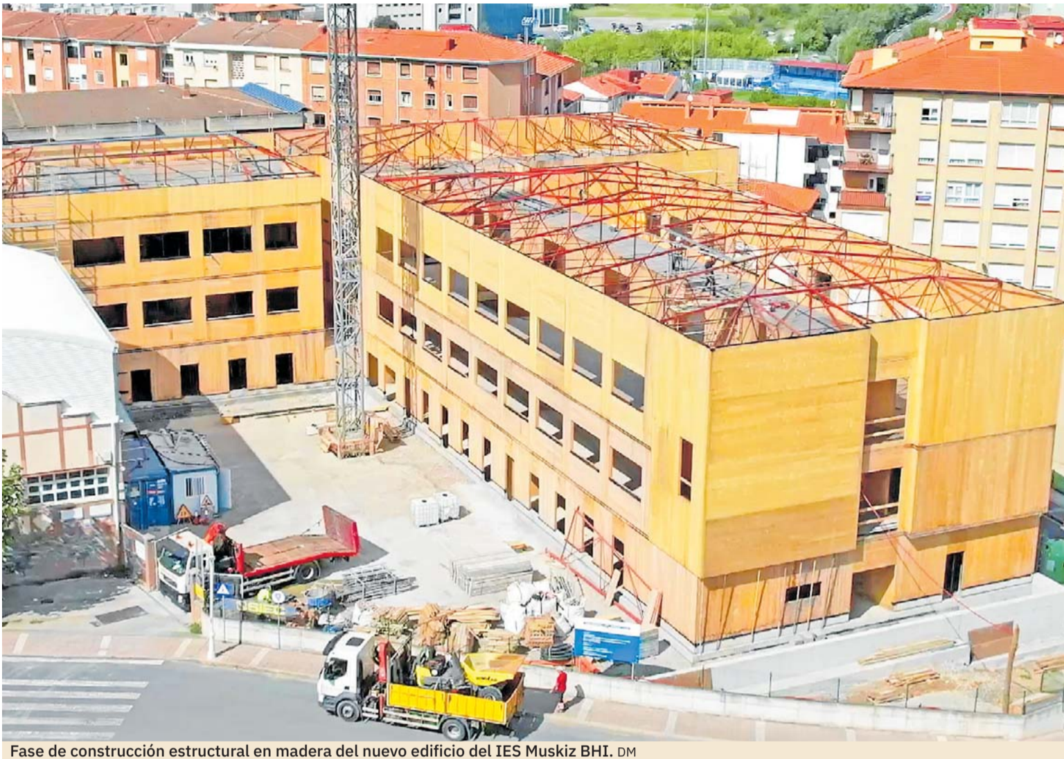
Fase de construcción estructural en madera del nuevo edificio del IES Muskiz BHI. DM
