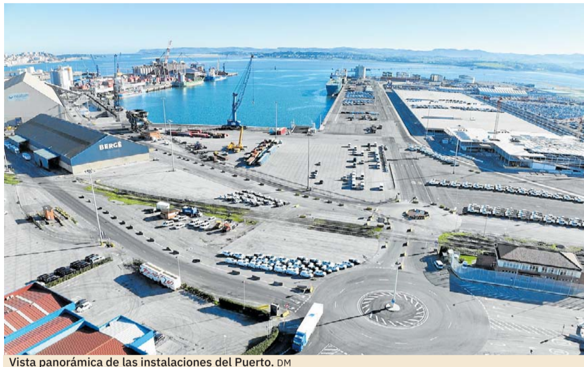
Vista panorámica de las instalaciones del Puerto. DM
