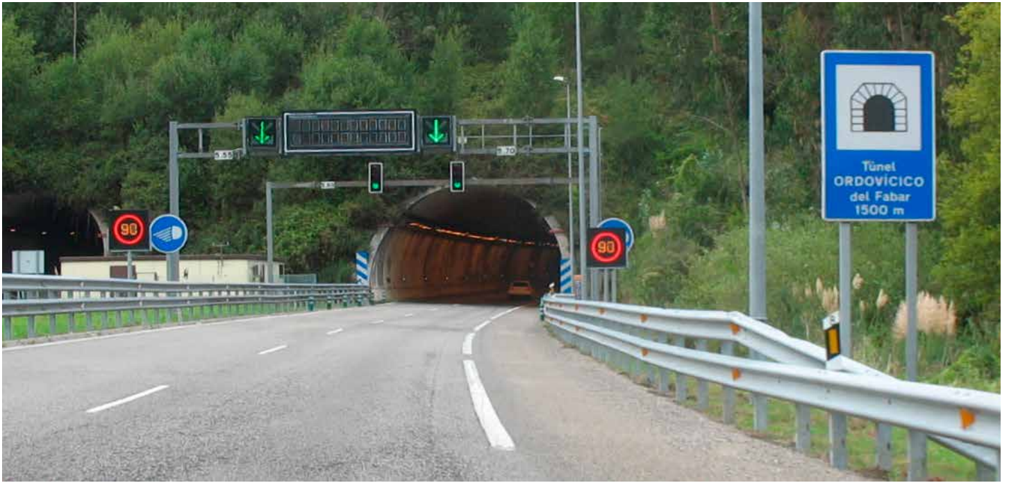
Túnel Ordovícico del Fabar
