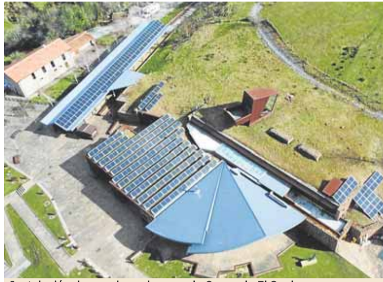
Instalación de paneles solares en la Cueva de El Soplao. DM
