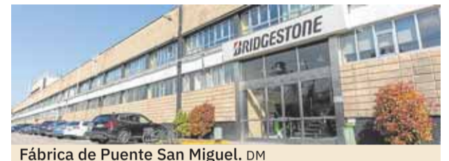
Fábrica de Puente San Miguel. DM
