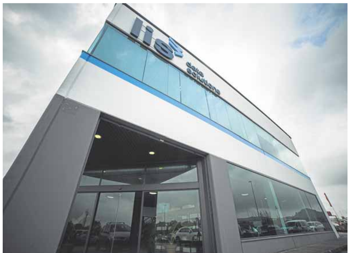
Instalaciones de LIS Data Solutions en Santa Cruz de Bezana. DM
