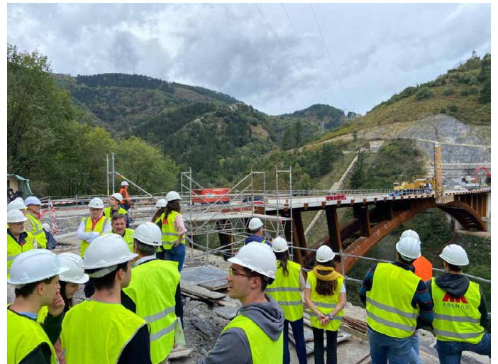
Viaducto del Bolintxu
