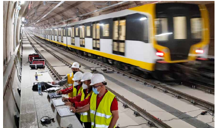
Equipo del LADICIM haciendo pruebas en las Líneas del Metro de Lima.
