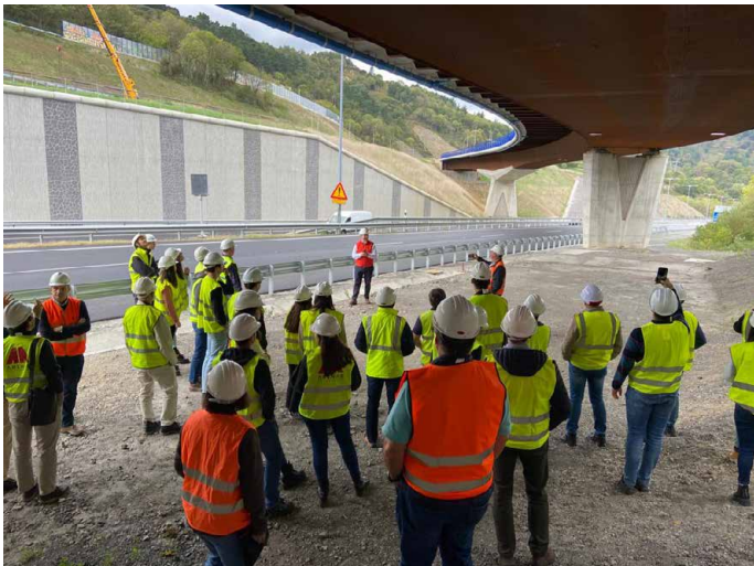
Viaducto sobre la AP-68 en Arrigorriaga
