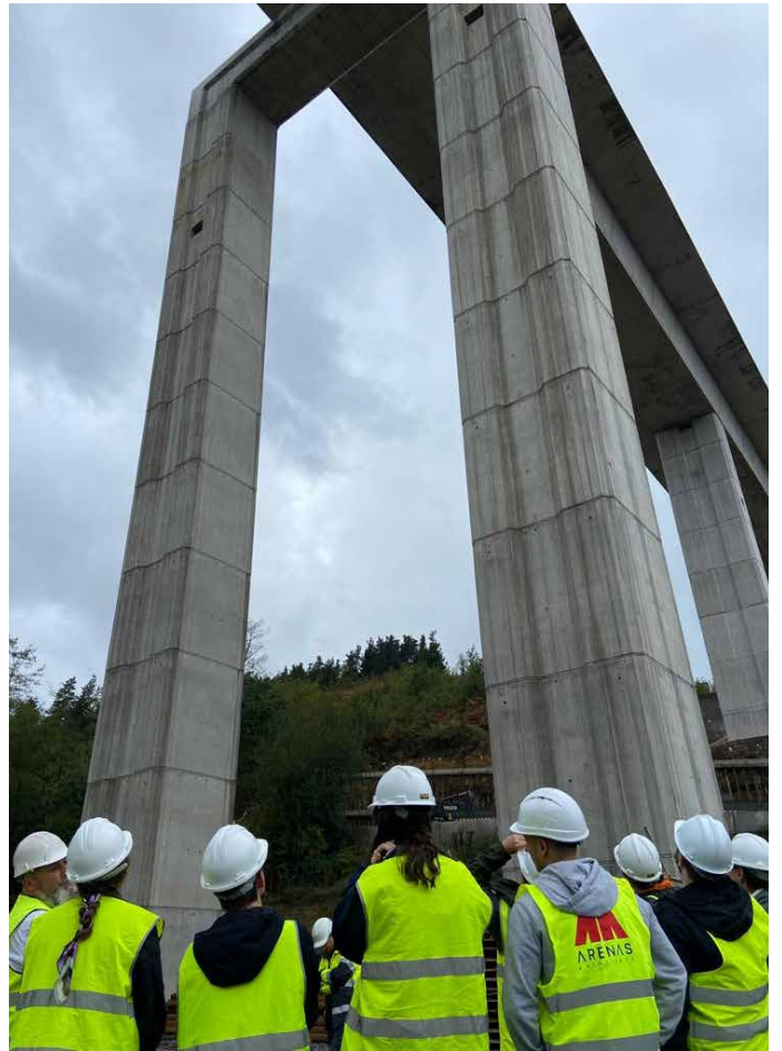
Obras de la línea de alta velocidad
