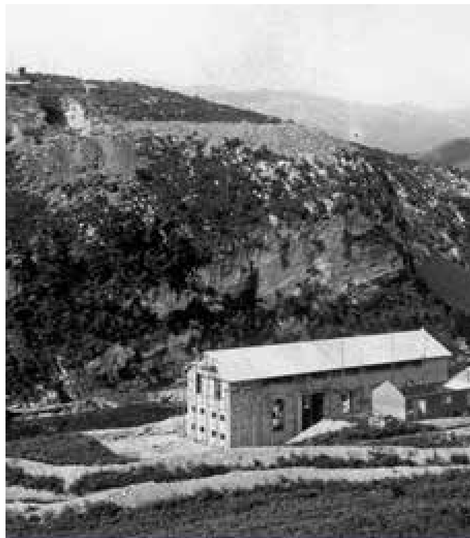
En esta imagen se observa, arriba y al fondo, la obra del depósito de carga, y en primer término el edificio de la central, de 3 alturas y 615 m 2 de superficie total construida.
