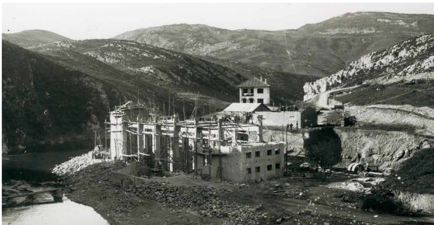
Y en esta otra, además del desarrollo de la obra de la central, se observa al fondo una construcción residencial. Se trata de un inmueble de dos plantas, con una vivienda en cada una de ellas, destinadas a personal técnico de la empresa que se haría cargo del funcionamiento y control de la central.
