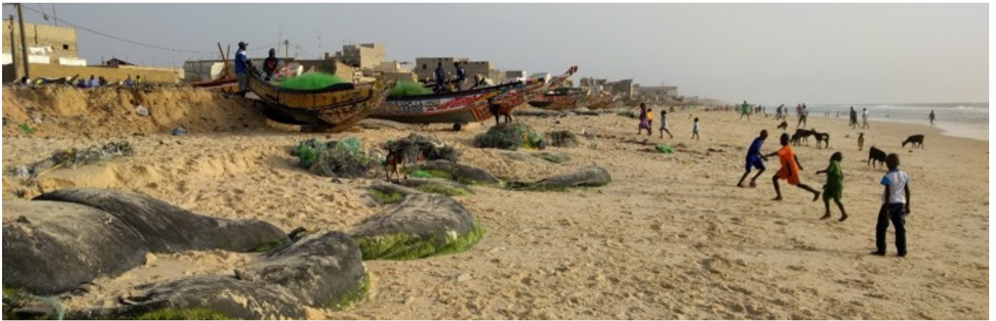
Protección costera fallida en Senegal, donde los restos de gaviones crean un problema de seguridad y contaminación.
