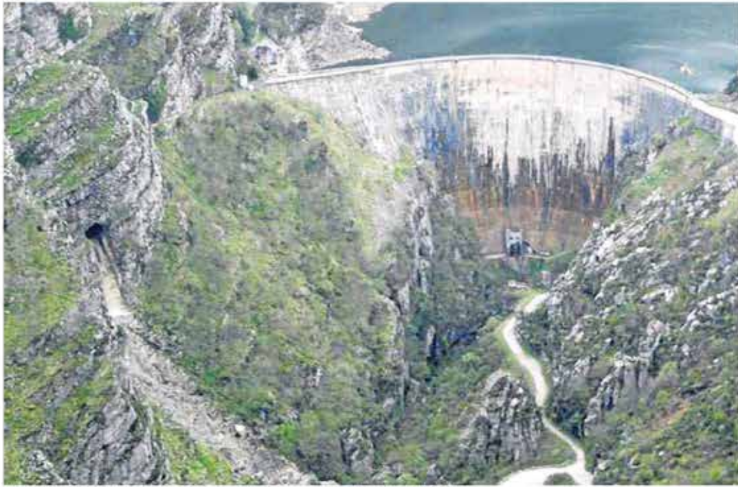
Innovadora. La Cohilla es la principal presa del aprovechamiento hidráulico del río Nansa.
