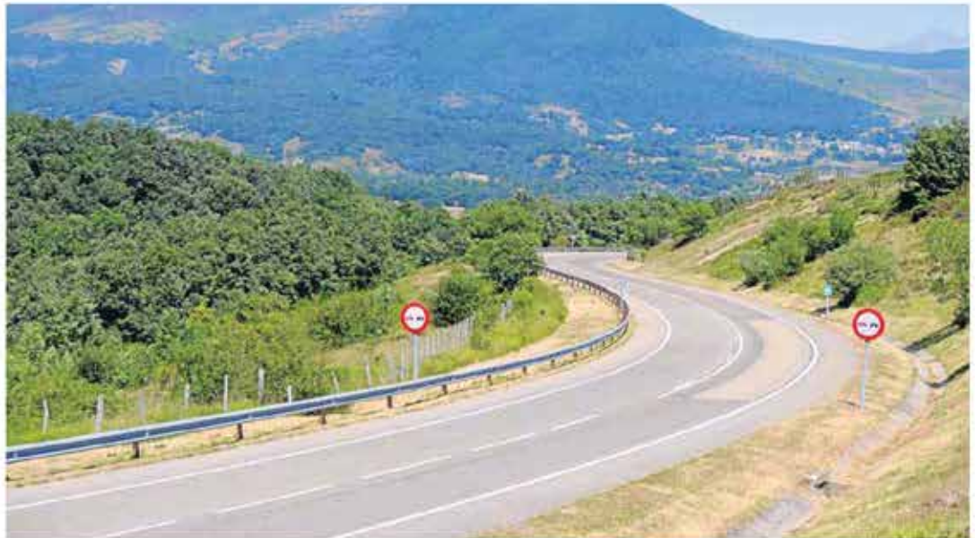
Imagen de uno de los puntos de la carretera. GM
