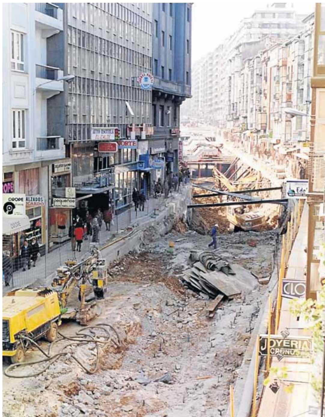
Hito. De la importancia de la obra dan idea los 30.000 metros cúbicos de material excavados.:: ciccp
