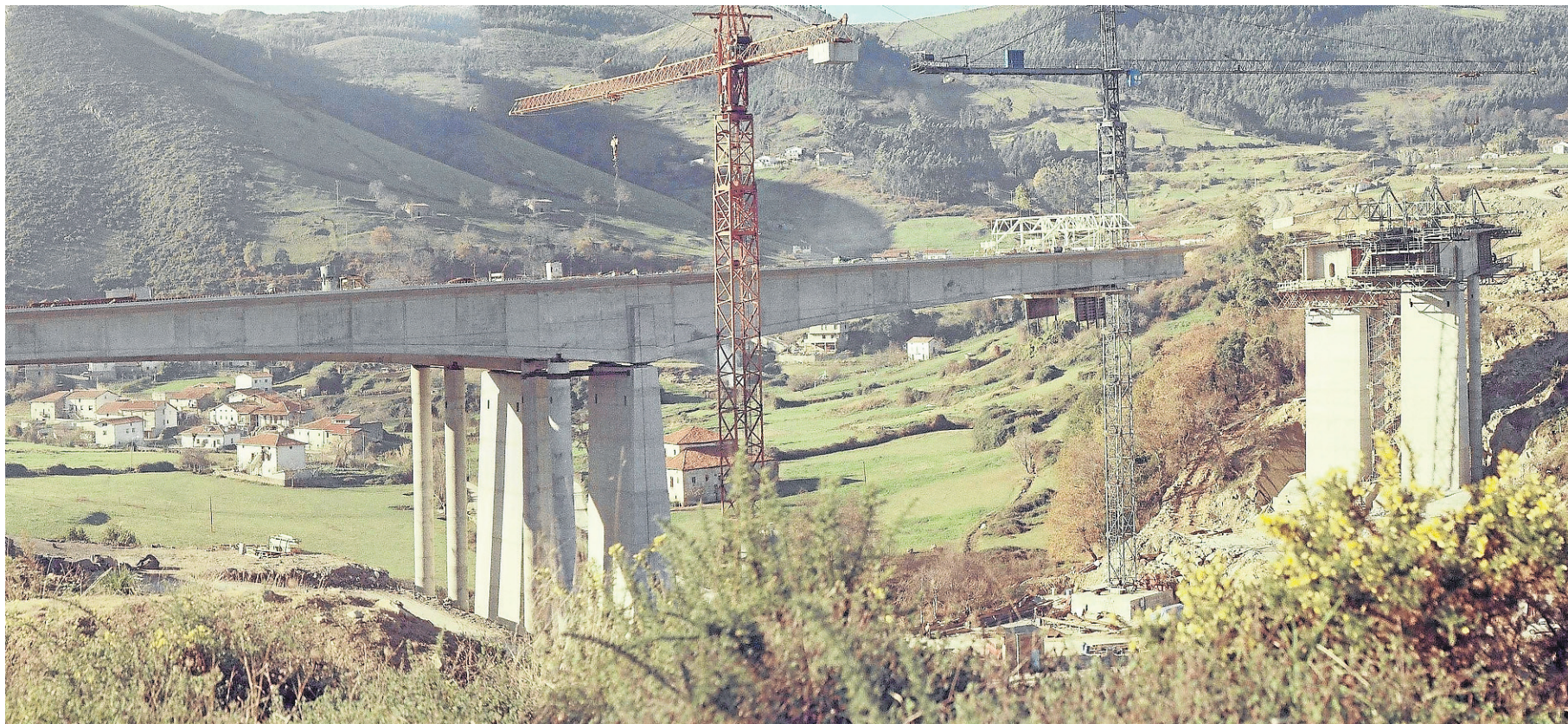
En obras. El tramo El Haya-Castro resolvió el difícil paso de la carretera N-634 por el Ato de Saltacaballo. iccp
