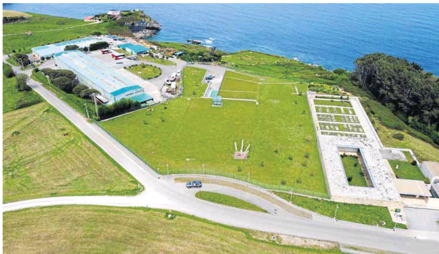
Vista aérea de la EDAR subterránea de Comillas. INTEDIS
