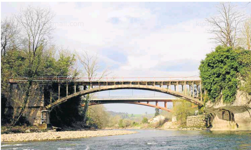
En primer término, el puente proyectado por José Eugenio de Ribera en 1902. Al fondo, la nueva estructura.
