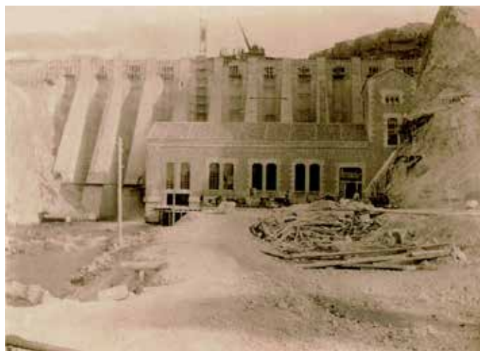
Presa Burgomillado en construcción
