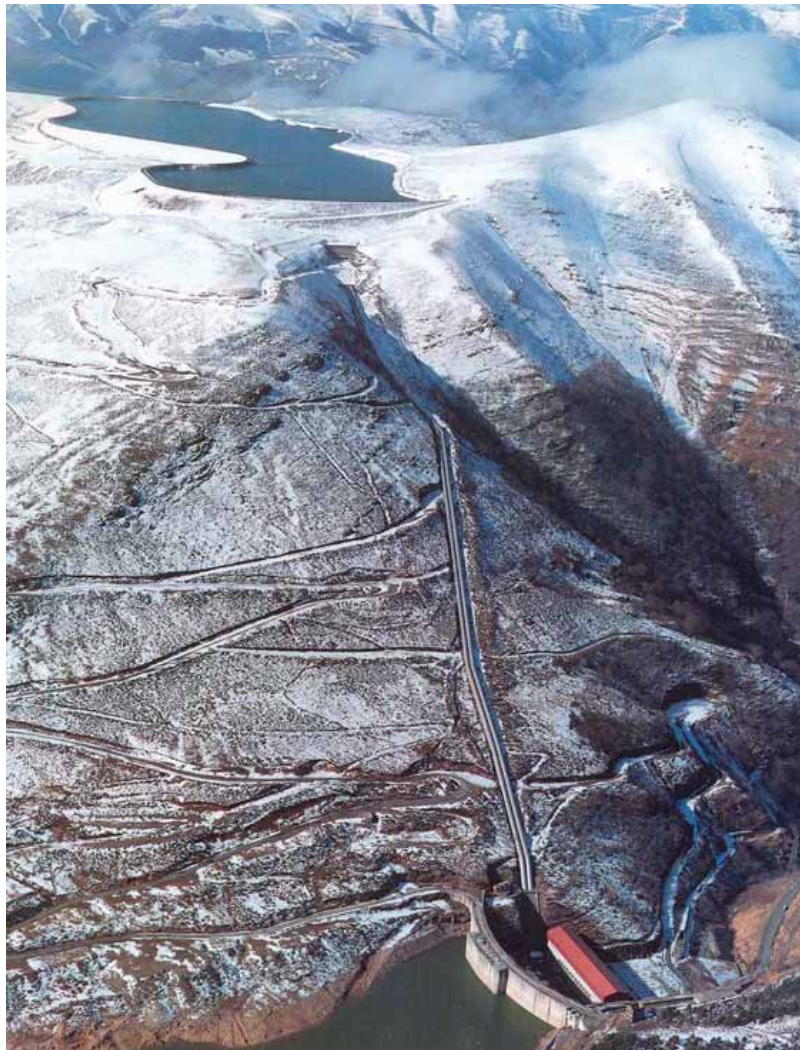
Nexo. Imagen aérea de archivo de los embalses de Alsa y Mediajo y de la tubería que les une.
