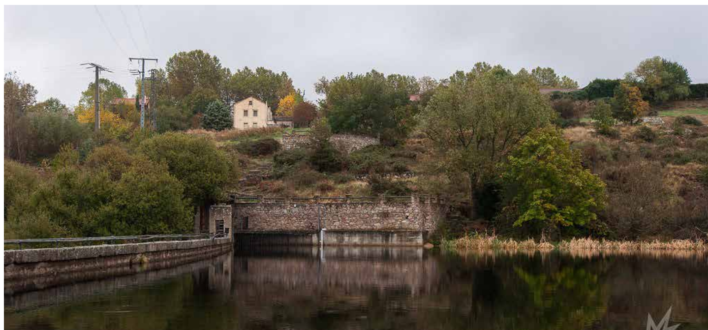
Central hidroeléctrica en el río Valsain, el Salto El Olvido para abastecer de agua a La Granja Valsain y La Pradera
