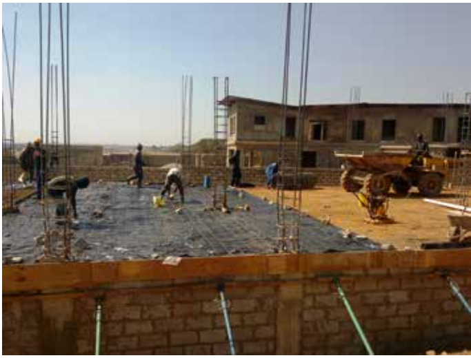
Construcción de bloque de oficinas en Lusaka
