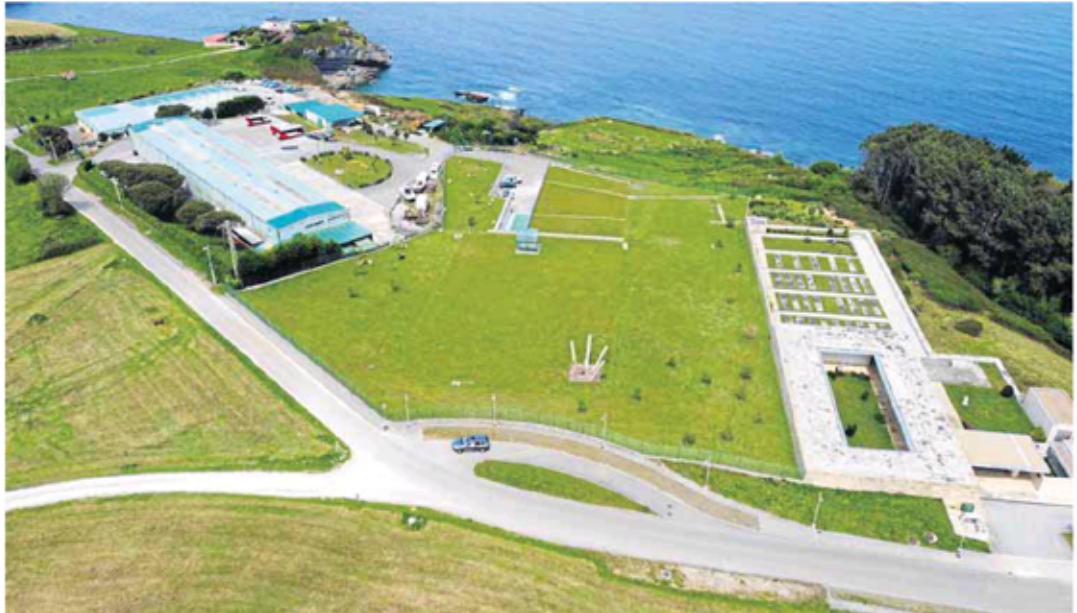
Vista aérea de la EDAR subterránea de Comillas. INRECO
