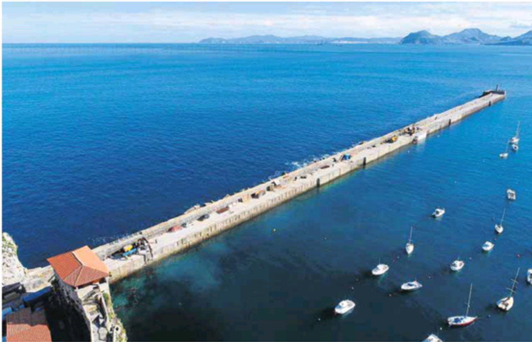
Panorámica del dique-rompeolas de Castro Urdiales. DM
